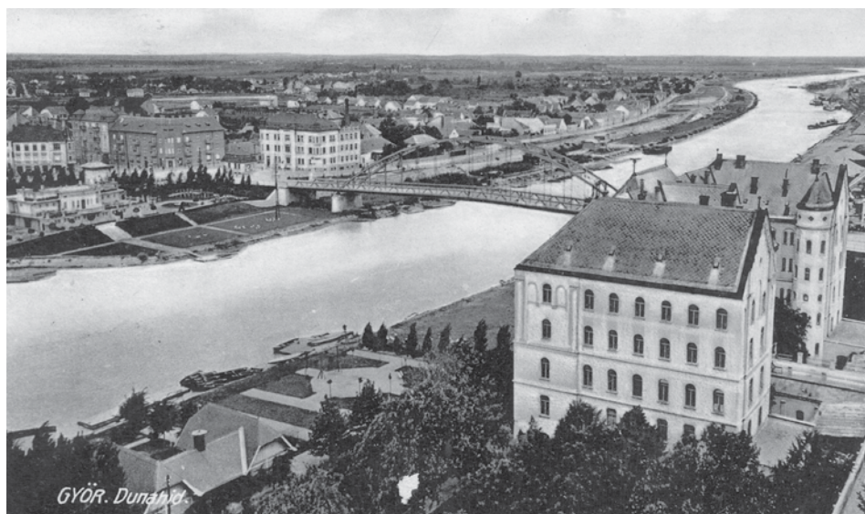
A Belvárost és Révfülszék összekötő Kossuth híd, Révfülszék látképe. A képen látható többek között a Káptalándomb részlete, valamint a Csermák-ház és a Győri Torna és Evezős Egyesület épülete, 1933. (Forrás: Dr. Kovács Pál Könyvtár és Közösségi Tér gyűjteménye).
